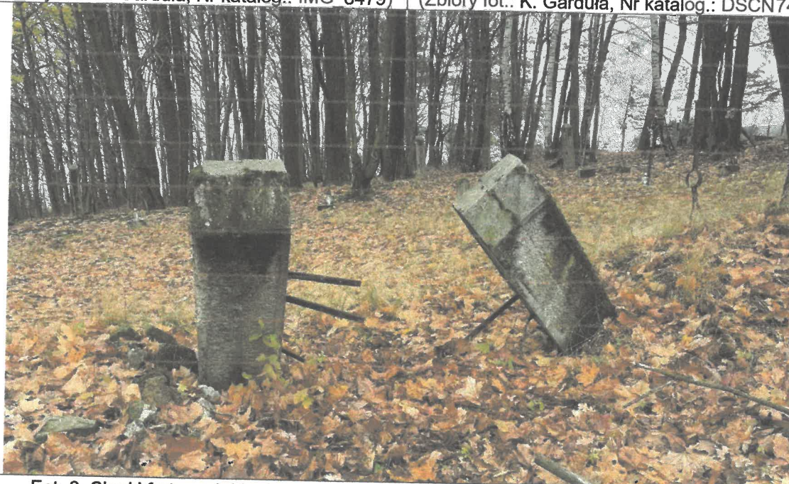
Fot. 8. Słupki furty - zdobienia oraz metalowe elementy do mocowania drewnianych słupów służących do zawieszenia furty, 2022 r. (Zbiory fot.: K. Garduła, Nr katalog.: IMG 8512)
